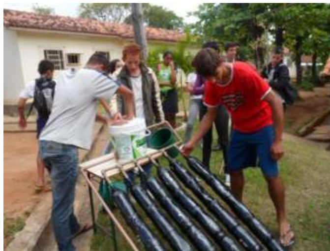
TERMINANDO O AQUECEDOR SOLAR
