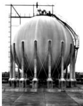
Figura 1. Vaso de pressão esférico (WIKIPÉDIA, 2010).
