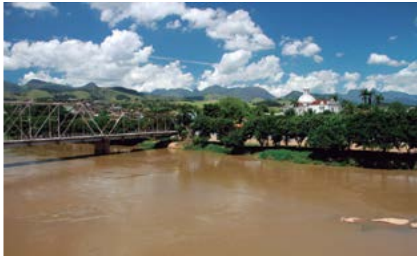
Figura 12.5: Ponte sobre o Rio Paraíba do Sul, em São Fidélis.
