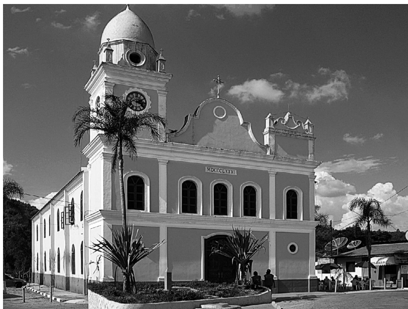
Figura 7.3: Igreja Matriz de Araçariguama.
