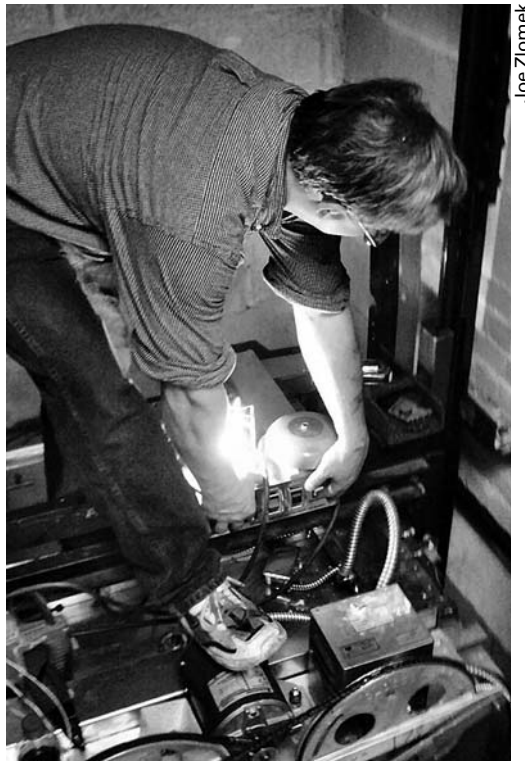
Figura 13.1: Manutenção do elevador.
