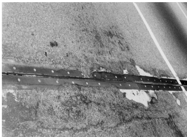
Figura 5.5: Junta de dilatação entre duas seções da pavimentação de um viaduto.
