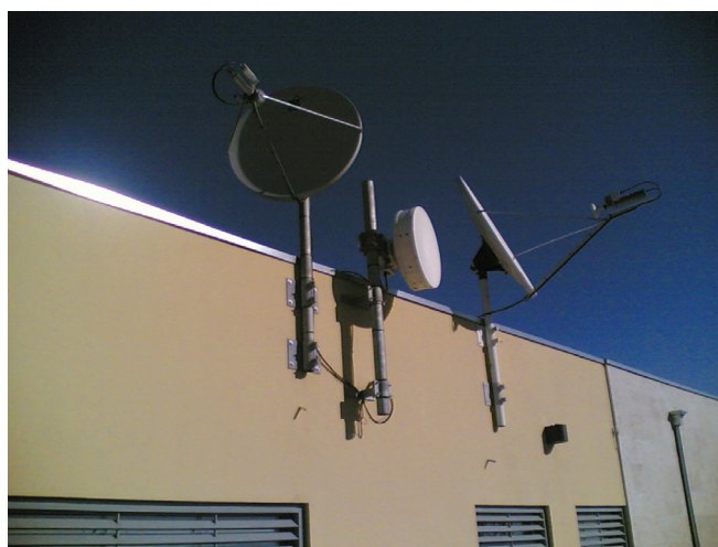
Figura 18: Antenas utilizadas para acesso, via satélite, à internet e serviço telefônico.
