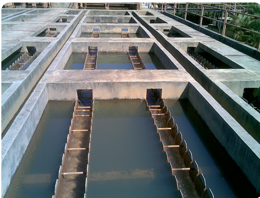
Figura 10: Tanques de decantação de uma estação de tratamento de água.
