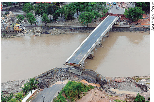
Figura 3.6: Ponte destruída por enchente ocorrida no ano de 2010 em Pernambuco.
