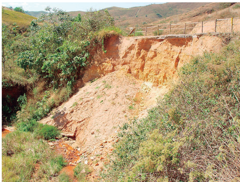
Figura 3.2: Movimento gravitacional de massa em encosta ameaçando a estabilidade da estrada vicinal, no alto da fotografia à esquerda. Volta Redonda, 2004.
