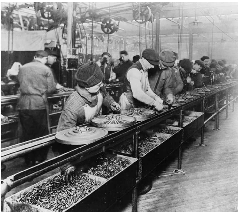
Figura 5.6: Foto da primeira linha de montagem móvel em 1913. Ford revolucionou o sistema de produção na indústria automobilística com sua linha de montagem móvel. A produção em massa concebida e implementada por Ford ficou conhecida como Fordismo.
