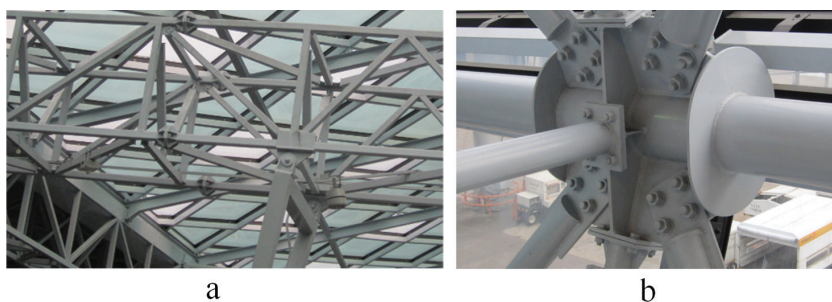
Figura 7.1: As treliças espaciais permitem cobrir grandes vãos, com um número limitado de colunas (a). Por esse motivo, são muito utilizadas em aeroportos e centros de convenções. As articulações entre as barras podem ser feitas mediante parafusos (b).
