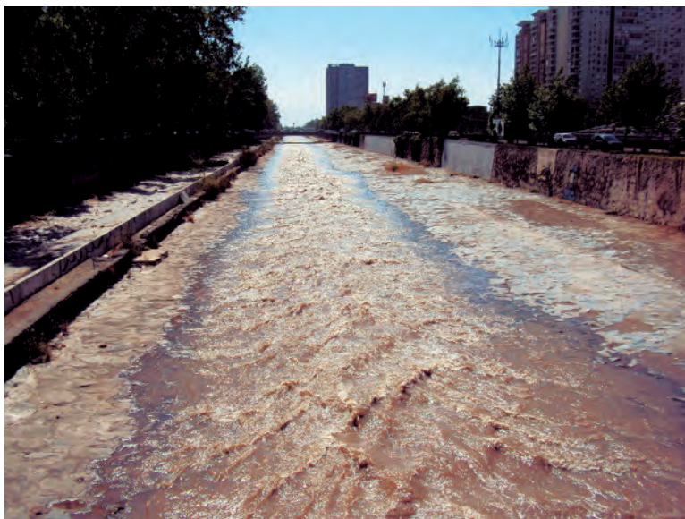
Figura 9.1: Canal retificado em área urbana com manutenção de margens para transbordamento em enchentes excepcionais (Santiago, Chile).
