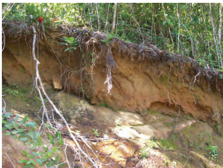
Figura 7.10: Detalhe de contato solo/rocha em escorregamento translacional na estrada Parati-Cunha (RJ/SP).
