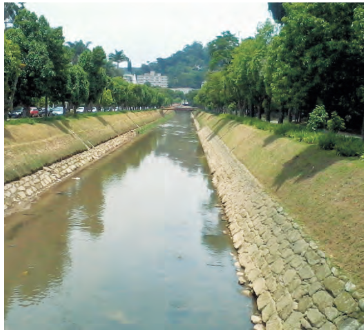
Figura 9.2: Exemplo de obra realizada diretamente na área do canal, com fins de retificação do canal e evitar inundações. Rio Quitandinha – Petrópolis – RJ.
