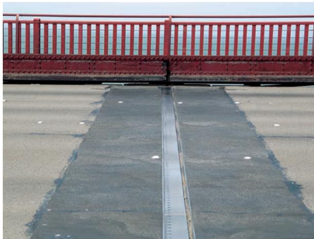
**Figura 10.1:** Juntas de dilatação da ponte Golden Gate (Califórnia, EUA), utilizadas para absorver a variação volumétrica dos materiais e os efeitos inerentes a cada tipo de estrutura. Fonte: [https://commons.wikimedia.org/wiki/File:Expansion\\_joint\\_Golden\\_Gate\\_Bridge.jpg](https://commons.wikimedia.org/wiki/File:Expansion_joint_Golden_Gate_Bridge.jpg).
