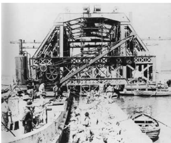
Figura 4.2: A imagem retrata a construção de uma muralha para o cais do porto do Rio de Janeiro, com ensacadeira e guindaste. Desde o século XIX, a modernização dos nossos portos foi uma questão importante para os interesses comerciais brasileiros.
