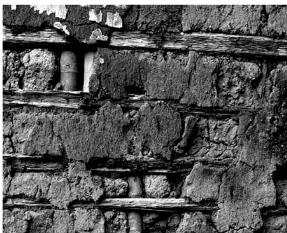
Figura 17.2: Casa de pau-a-pique, típica das áreas rurais do interior do Brasil.
