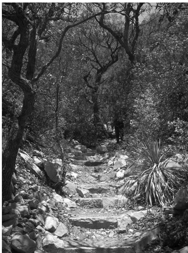
Figura 11.12: Rochas adequadamente distribuídas e distanciadas no solo são ótimos recursos para criar escadas e degraus naturais que não agredem o visual da trilha e proporcionam uma ótima experiência para o caminhante.
