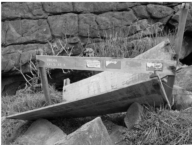
Figura 23.6: Placa de sinalização na Trilha da Costa Azul, em Fernando de Noronha, deteriorada pelo tempo e pela maresia e que deveria ser substituída.
